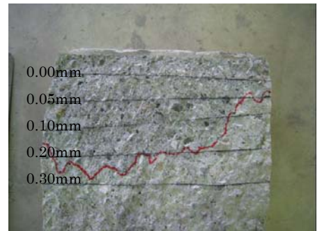
写真-2 ひび割れ充填状況 (No. 3)
