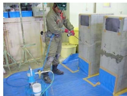
写真-1 ひび割れ注入状況
