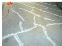
注入専用アンカープラグ取 付け、目止めシール
