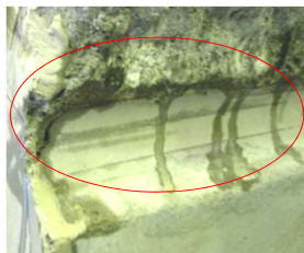
背面側から注入材を確認 (ひび割れ幅=0.01mm)
