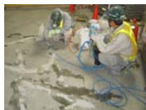
高圧注入 (TSクラックフィラー注入)
