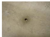
撤去 目止めシールおよびアンカー プラグは全て撤去する
