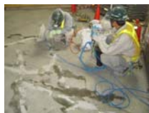
高圧注入 (TSクラックフィラー注入)
