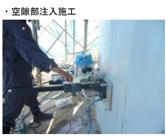
風車基礎部補強工事
