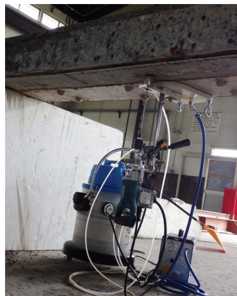
写真 10 下面からの削孔状況
