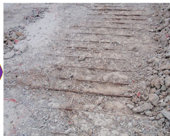
舗装撤去後の床版上面の損傷状況
