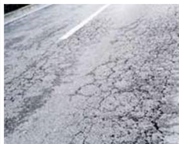
アスファルト舗装面の状態
