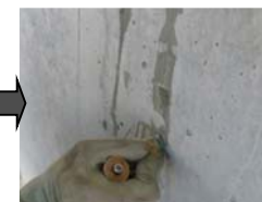
上部注入口から材料流出
