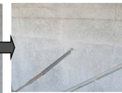
施工完了(止目材撤去)
